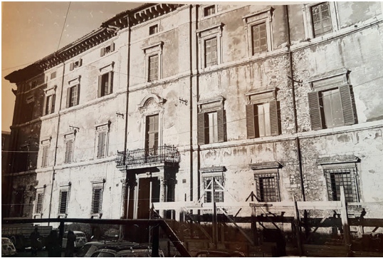
Fig. 4. - Palazzo Manzoni Ansidei. A destra del portone d'ingresso, si vede la facciata di palazzo Gregori, incorporato in palazzo Manzoni Ansidei, Fotografia del 1960 circa, Perugia, Archivio di Stato, Fondo Ottorino Gurrieri, fasc. 64, foto n.n.
